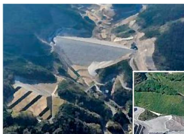
荒瀬ダム (肝属中部地区) 平成29年3月より、ダム横の沢水を利用して、暫定取水を開始しています。
