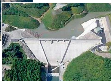
谷川内ダム(曾於北部地区)供用中！
