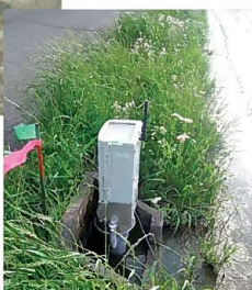
多機能自動給水栓設置の様子
