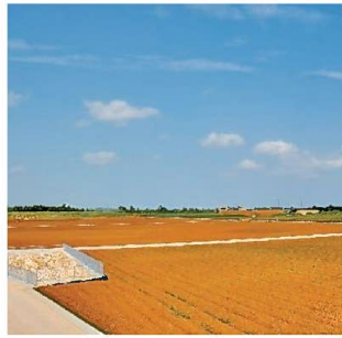
基盤整備の状況(宮古伊良部地区)
