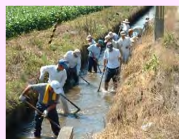
水路の泥上げ
