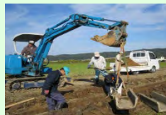
コンクリート水路の更新
