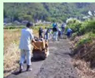
未舗装農道の舗装
