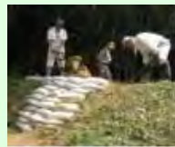
漏水箇所の補修
