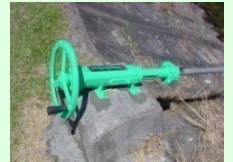
ゲート、バルブの更新
