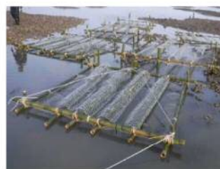
耐久性を改善した金網ロール式着生材の設置
