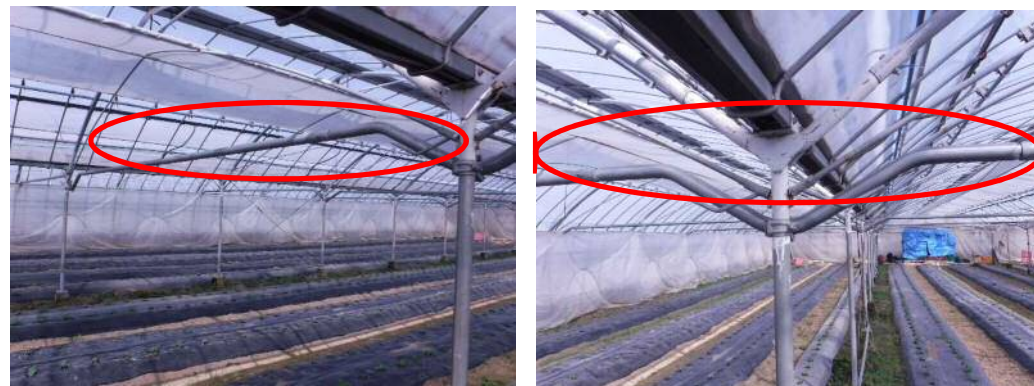
水平梁(5m間隔で設置)
