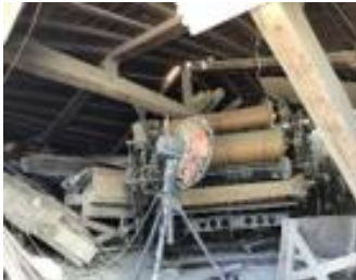
いぐさ織機の損壊 (八代市)
