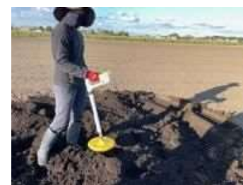
金属探知機で位置確認
