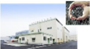
➤ 汚泥燃料化センター
