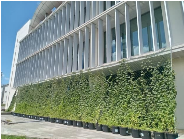
日明浄化センター
