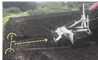
ほ場面の傾斜・均平化作業
