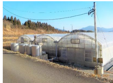
装置ハウス全景
