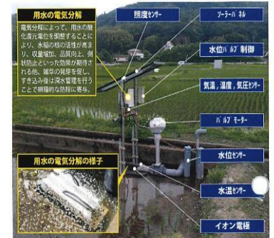
水位自動調整バルブ付き電気分解装置
