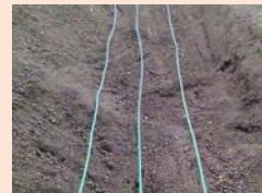
電熱線設置の様子
