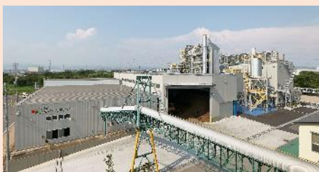
岐阜バイオマスパワー全景
