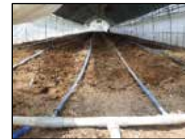
灌水チューブ設置
