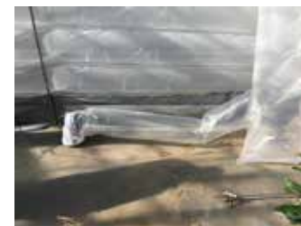
送風機取付時
