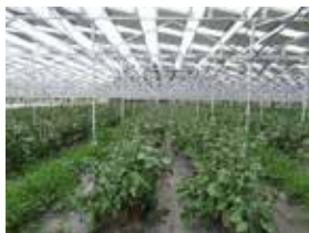
農地に設置された 営農型太陽光発電施設
