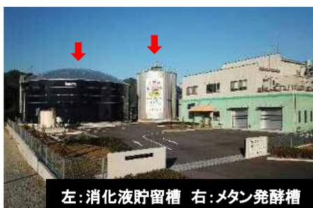
左：消化液貯留槽 右：メタン発酵槽
