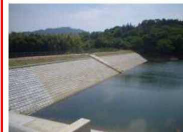
整備されたため池
