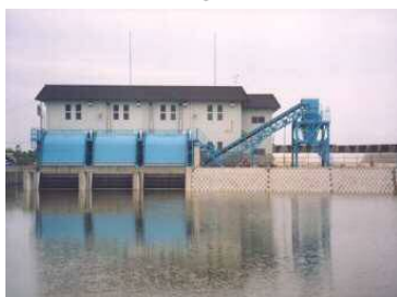
排水機場の整備
