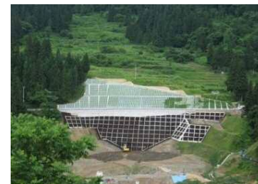
地すべり対策工事の完了
