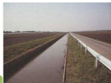
排水路の整備
