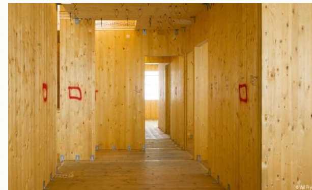
CLT建築物の内部 (イギリス共同住宅の例、内装工事前)
