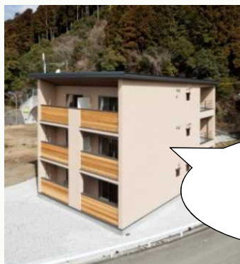
CLT建築物国内 第1号(高知県)
