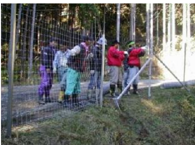
侵入防止柵の設置
