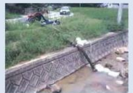
仮設ポンプを設置し、用水を確保
