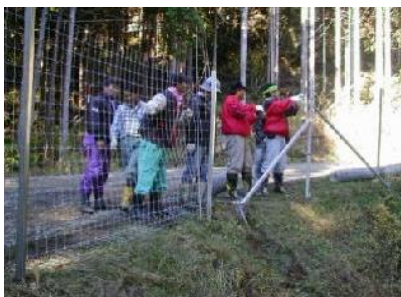
侵入防止柵の設置
