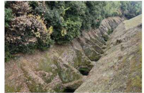
土砂堆積抑制の機能を持つ「鼻ぐり井手」(馬場楠井手用水)
