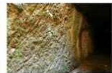
ノミの跡が残る藤ヶ谷水路 トンネル内部（広瀬井路）
