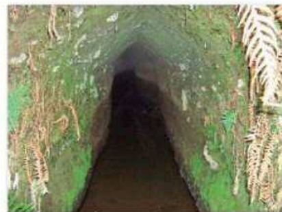
水路トンネル内部
