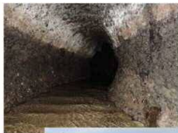
宝永隧道内部
