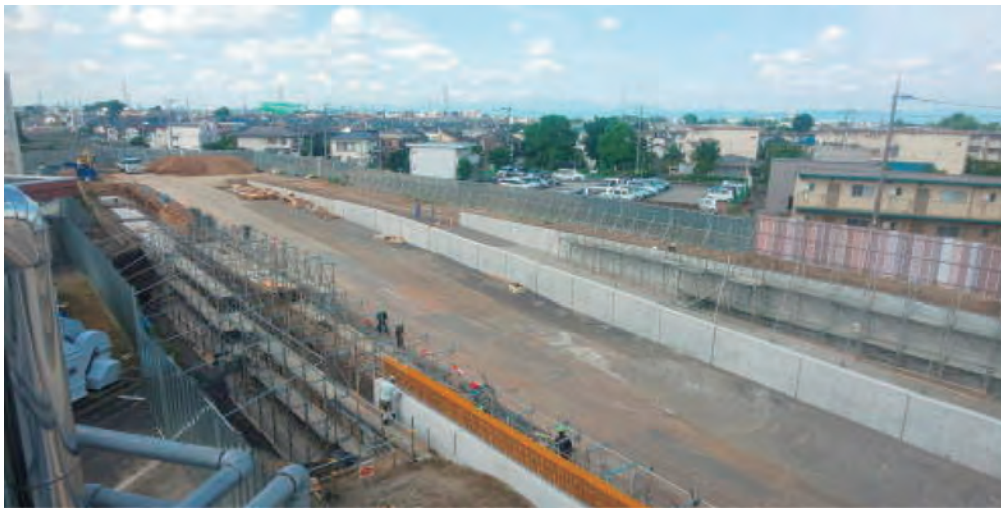
①令和２年３月撮影：総合検査棟から見た工事状況（建物等配置図の①からの景観）
