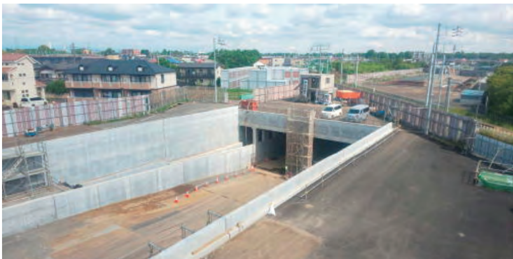
②令和２年３月撮影：総合検査棟から見た工事状況（建物等配置図の②からの景観）
