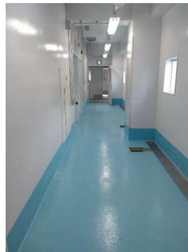
感染エリア清浄廊下
