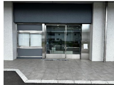
本庁舎 1階正面玄関
