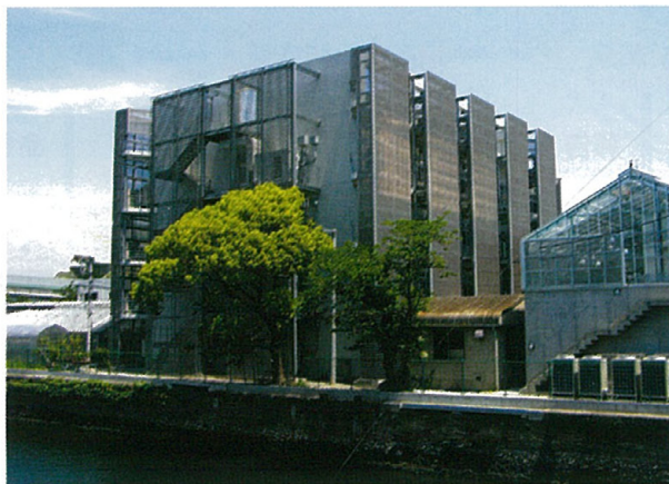
LMO分析施設を含む新設庁舎
