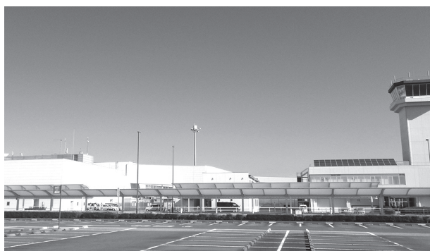
静岡空港出張所事務所(静岡空港ターミナル内)
