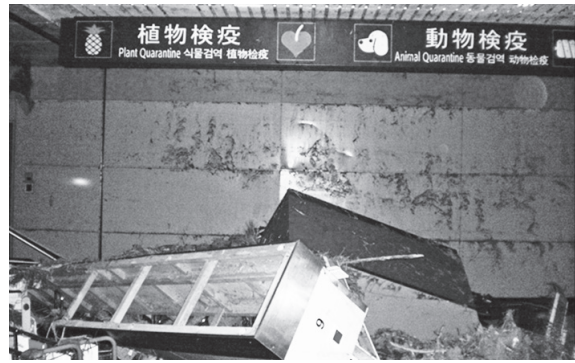
仙台空港植物検疫カウンター 被災状況
