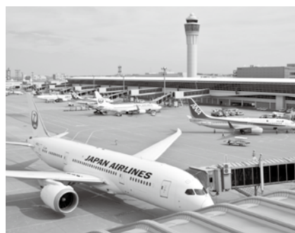
スカイデッキから見た中部国際空港
