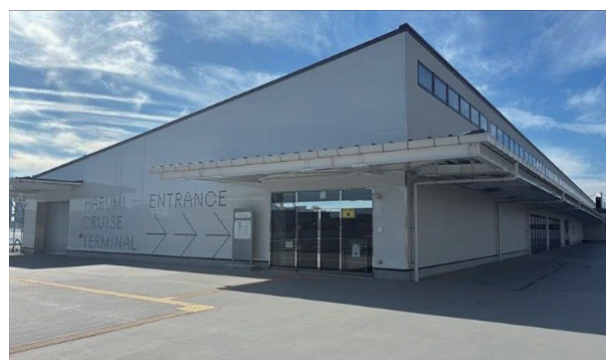
写真：晴海客船ターミナルの外観
