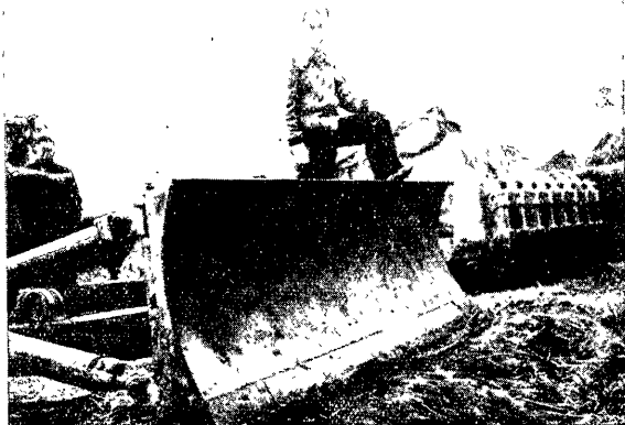
コラ改良用ブルドーザーの作業機。手前がスクレーパーで、これで表土をとり除いたり、地均しをする。後のシートをかけてあるのがブルドーザー（100馬力）で、右端にコラ層破砕用の爪がみえている。爪は半分土中にもぐつているが、そのジョイントまでの長さが1尺ばかり、1メートル間に8本ある。この爪ハンマーの総重は3トン。
