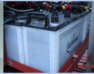
⑤バッテリー容量 24V-650AH (12V-130AH×10個)
