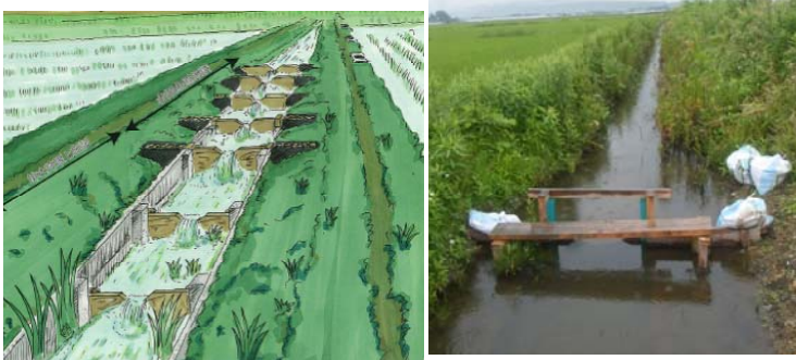
(A) 排水路の堰上げ
