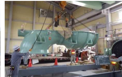
ポンプ設備の据付
