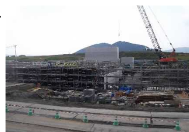
土木工事及び建築工事
