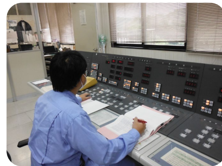
取水作業中 （揚水機場取水ポンプ 運転切替作業）
