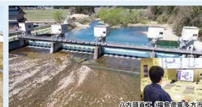
八方頭首工（福島県喜多方市）
