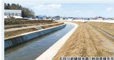
石持川幹線排水路（秋田県横手市）
