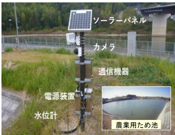
農業用ため池の水位を把握するための 遠隔監視機器の導入
