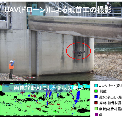
UAV(ドローン)を活用した機能診断
