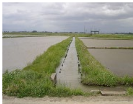
用排水路が未整備で 排水不良や湿害が発生
