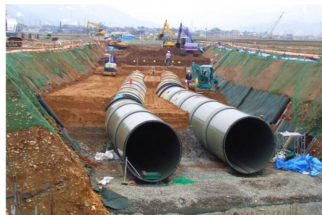
国営事業の実施状況 (左:幹線用水路の整備、右:工事監督職員による出来形検査)
