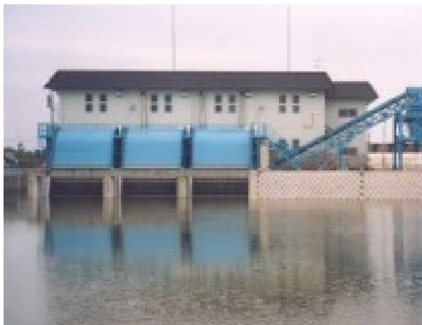
排水施設（排水機場）の能力向上・耐震化
