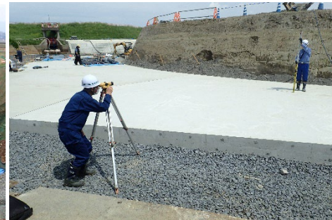
国営事業の実施状況 (左:幹線用水路の整備、右:工事監督職員による出来形検査)
