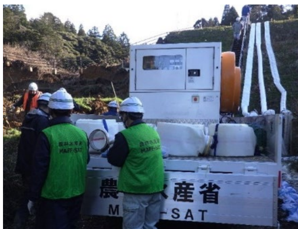
農業用ため池における排水ポンプの設置 （MAFF-SATによる災害復旧）
