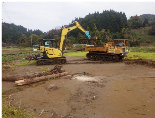
災害復旧（農地への堆積土砂・流木の撤去）
