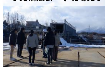
水路橋撤去工事現場見学
