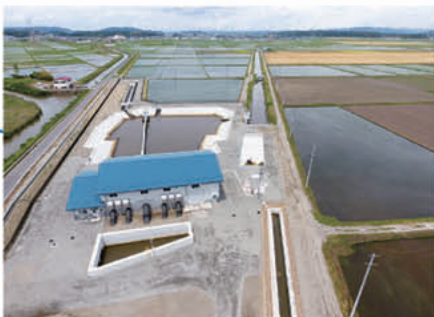
▲中区機場（宮城県）
