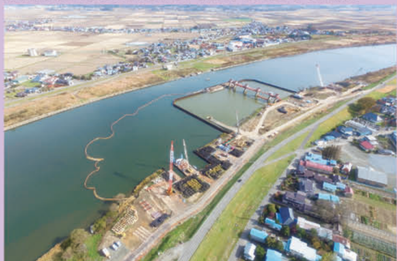
▲大柿ダム（福島県請戸川地区） 東北地方太平洋沖地震により、堤体天端等に亀裂が発生し、復旧工事（再盛立）を行いました。
