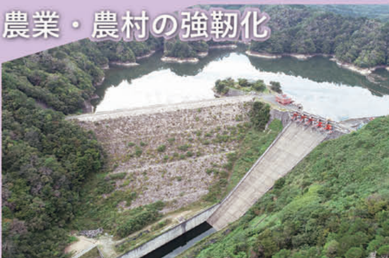
▲大柿ダム（福島県請戸川地区） 東北地方太平洋沖地震により、堤体天端等に亀裂が発生し、復旧工事（再盛立）を行いました。
