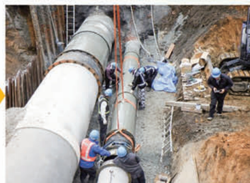
▲直轄災害復旧事業による幹線用水路の復旧
