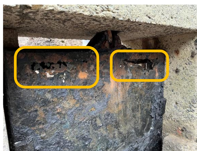
図3 金属腐食したゲート
