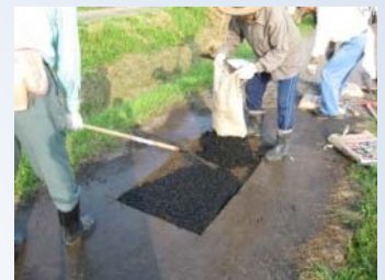
農道の部分補修
