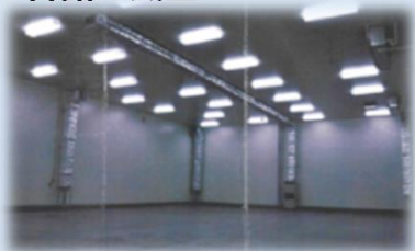
C : 甘藷貯蔵室
