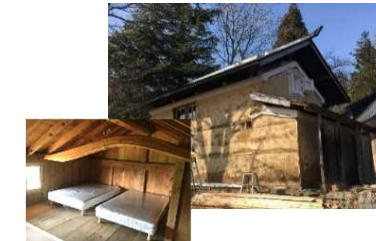
改修後の蔵 写真上:外観、下:内観
