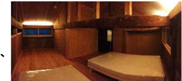
改修後の古民家 写真上:外観、下:内観
