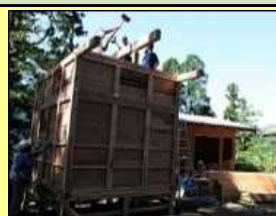
板倉建築の組み立体験
