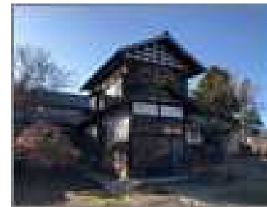
活用を検討している空き家(奥山源内邸)
