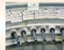
(集水ボーリング排水状況)
