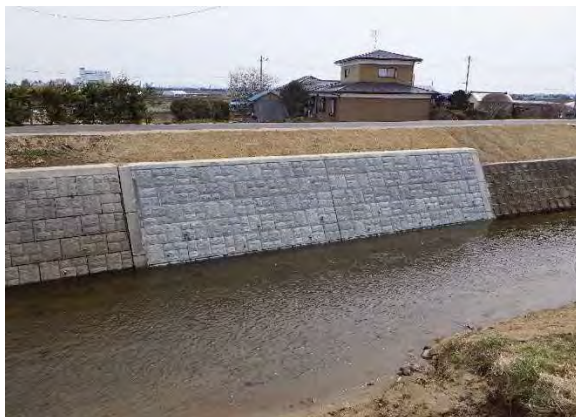
旧樋管撤去後
