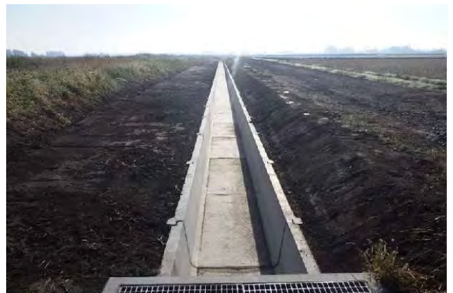
西古川用水路（改修後）
