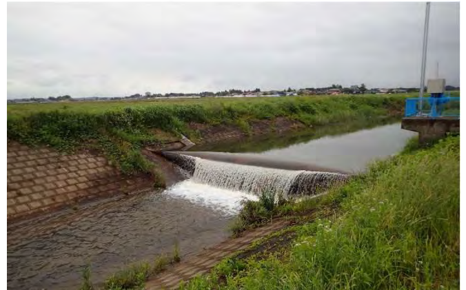
大筒堰頭首工（堰本体既設利用、一部機器等更新）
