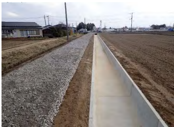
平柳用水路（改修後）
