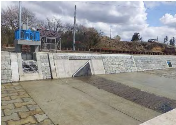
上堰頭首工（改修後）
