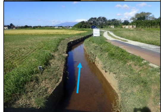
排水機（令和 5 ～ 6 年度整備） 導水路（令和 6 ～ 8 年度整備予定）
