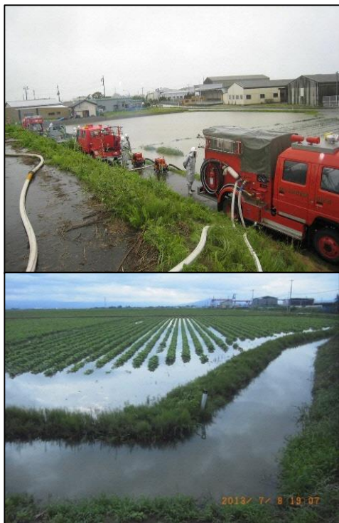
[荒田排水機の整備状況]
