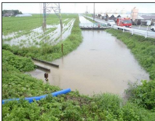
[二丁排水機の整備状況]
