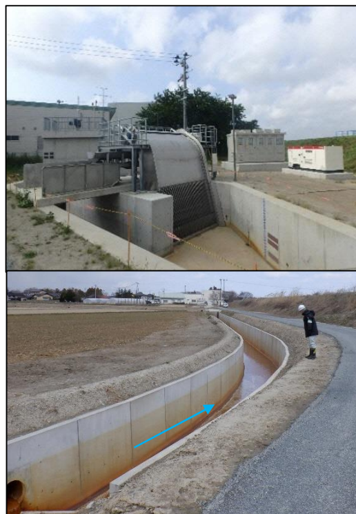
排水機（令和 4 年度完成） 導水路（令和 5 年度一部完成）
