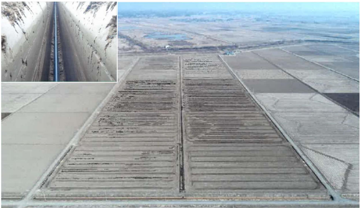
暗渠排水路工（区画整理後）
