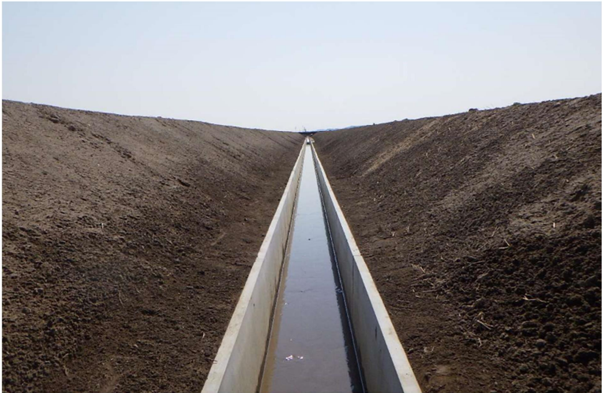
排水路工（区画整理後）
