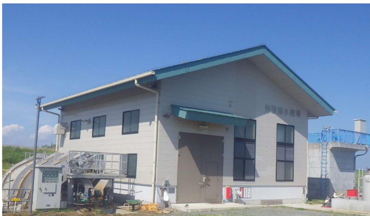
基幹水利施設（伸雨排水機場）整備後
