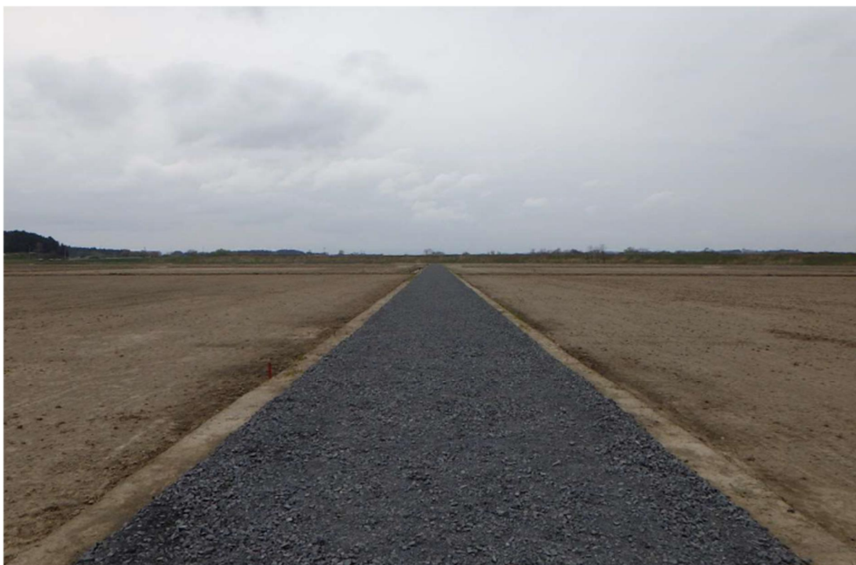
支線道路（区画整理後）
