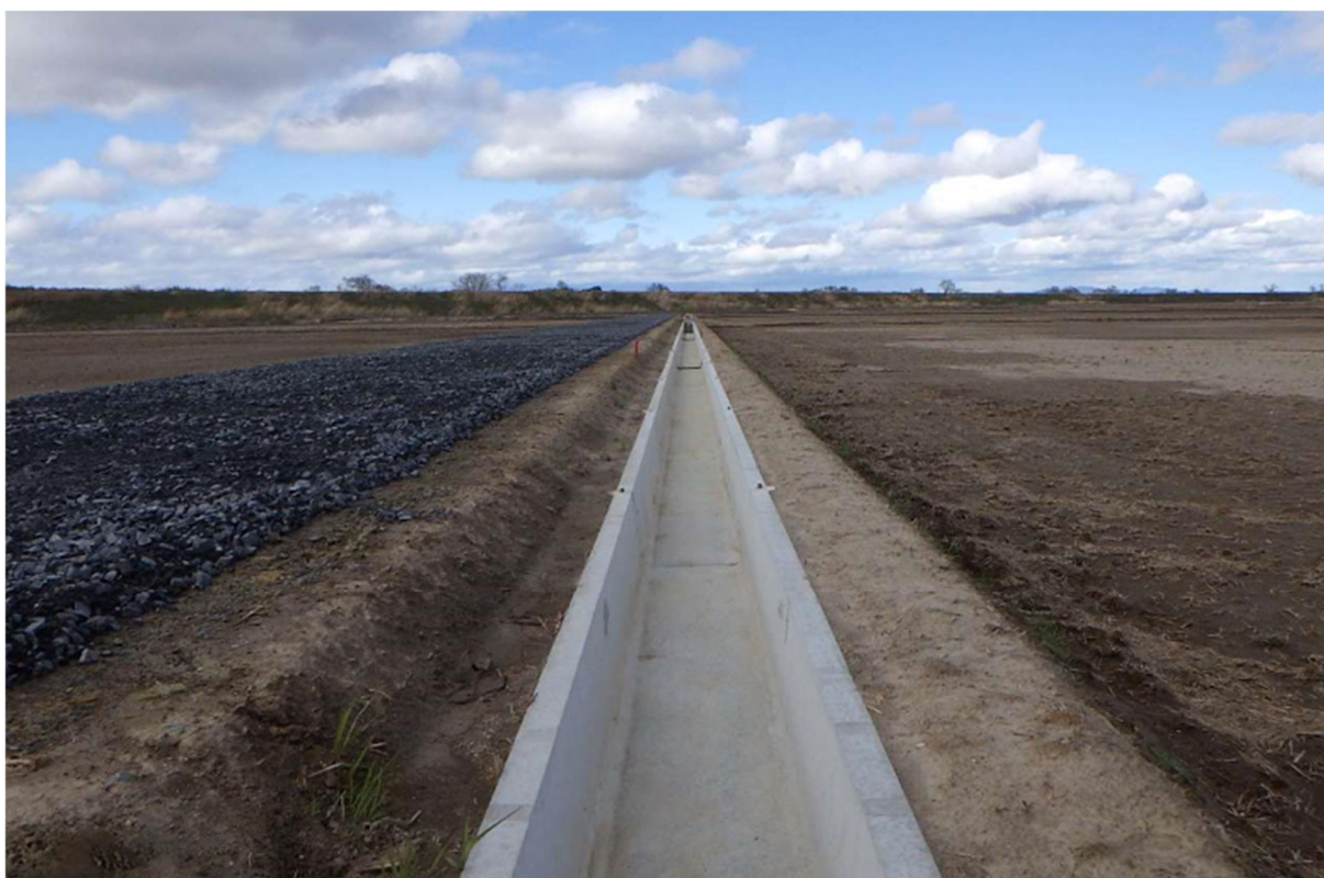
用水路工（区画整理後）
